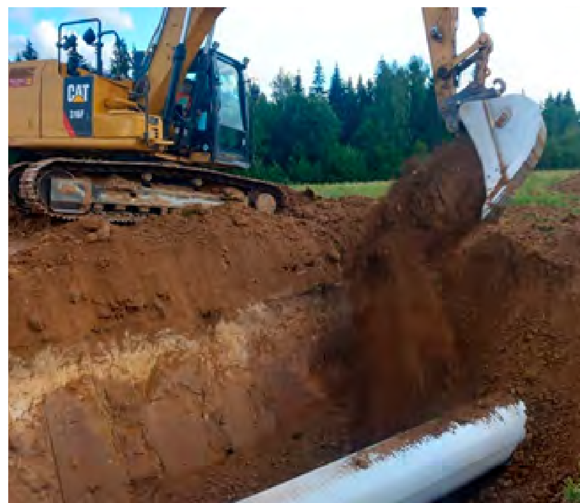
13. attēls. Cauruļvada posma nomainīšana. Iekšējās diagnostikas nodrošināšanai paredzētās pārbūves darbu apjoms.
