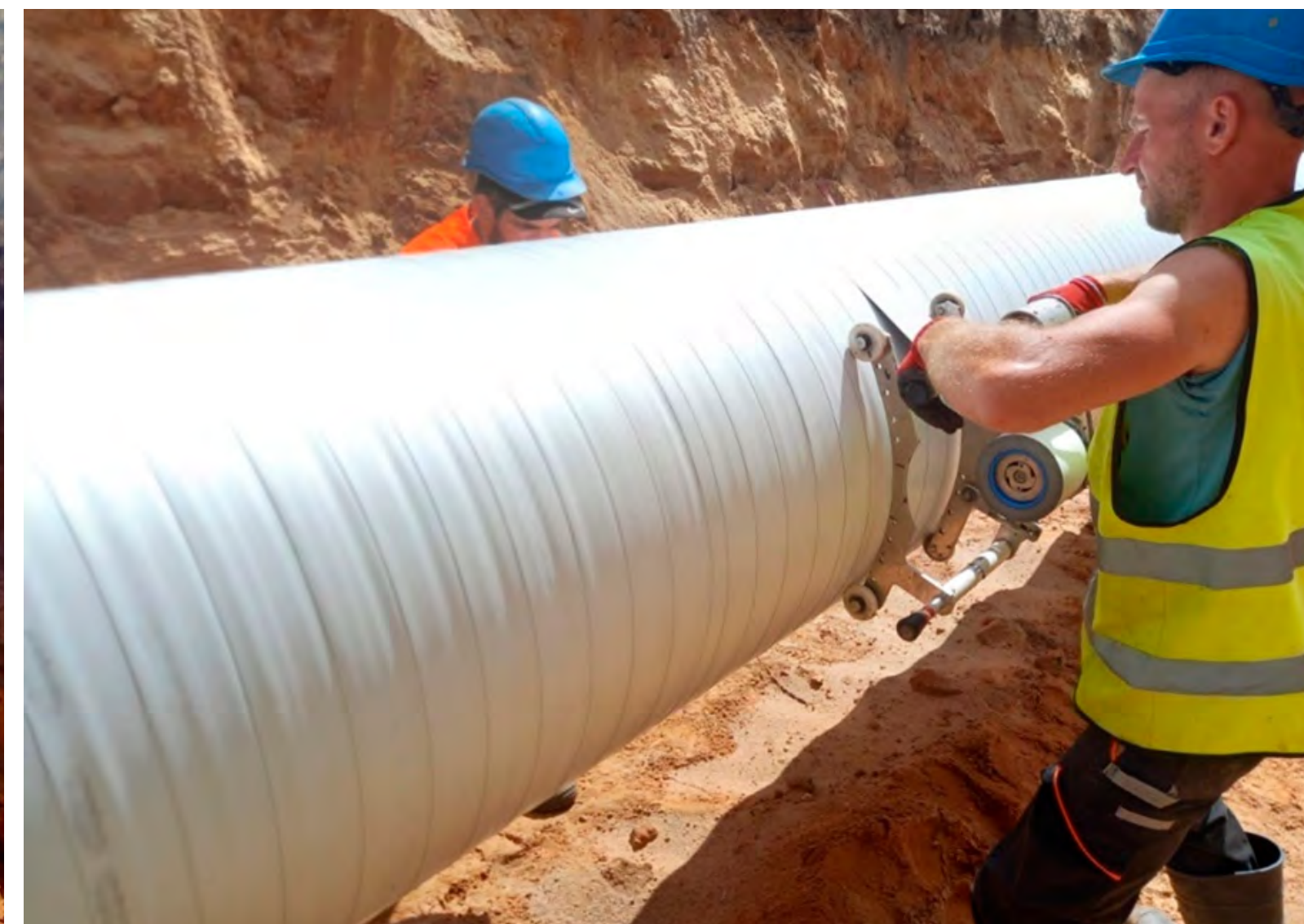
12. attēls. Cauruļvada pārizolācijas process. Vecās izolācijas noņemšana. Jaunās izolācijas uzklāšana
