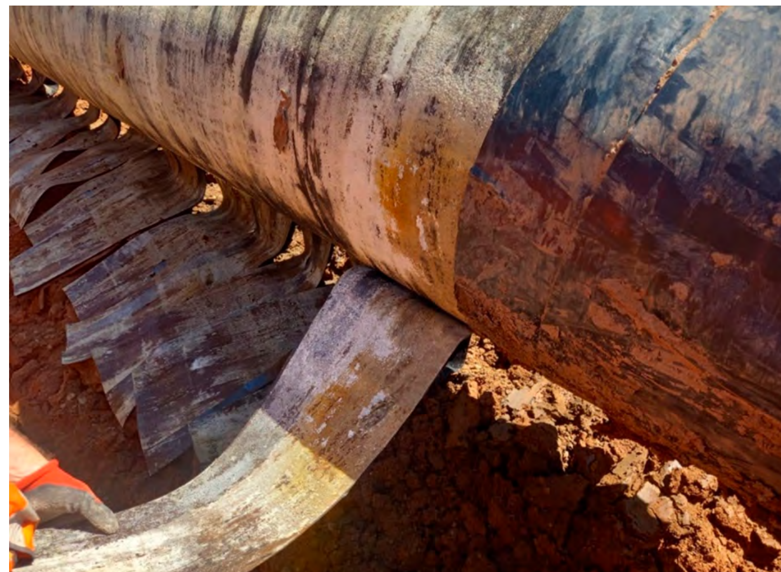
12. attēls. Cauruļvada pārizolācijas process. Vecās izolācijas noņemšana. Jaunās izolācijas uzklāšana
